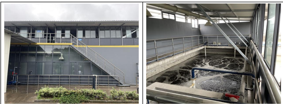
新污水处理站
